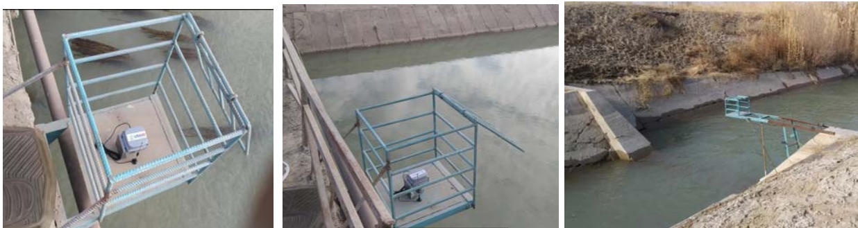
Рис. 12 Автоматизированные гидропосты на реке Мургаб
